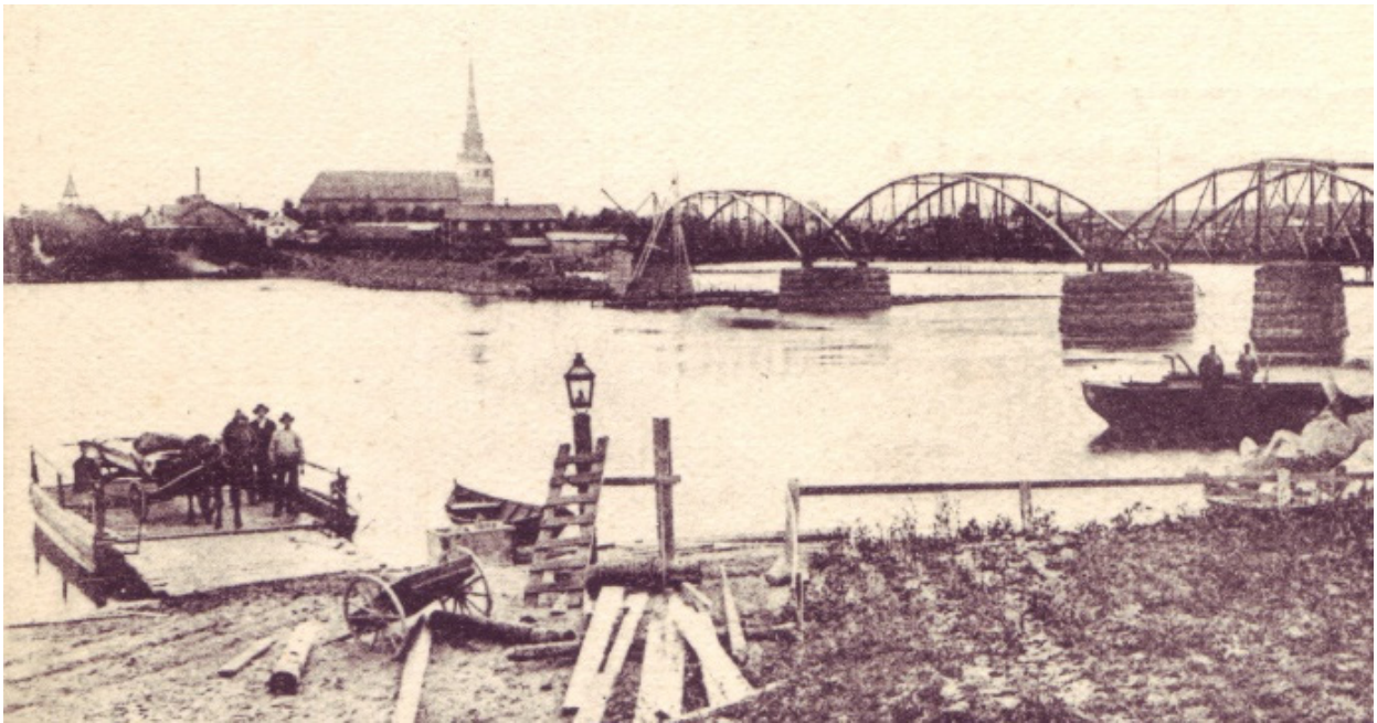
Bild 63. Den gamla färjan vid Dunkarsbo färjeläge syns till vänster i bilden. Bastubacksbron håller på att byggas. Foto ca 1902. Del av "Vykort från Mora" sid 80 (Jansson 2011).
