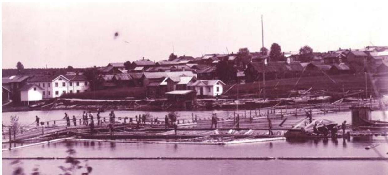
Bild 50. Flottbron sedd från Broåkern mot Noret. Den användes fram till 1896, då en kombinerad landsvägs- och järnvägsbro byggdes intill den nuvarande järnvägsbron. På bilden styr flottningsarbetare timmer förbi en upphöjning av flottbron som leder in i Mora skiljeställe. Den lilla vita stugan i fotots mitt är brostugan. Foto: Hjalmar Klingvall något av åren 1893-1896.
