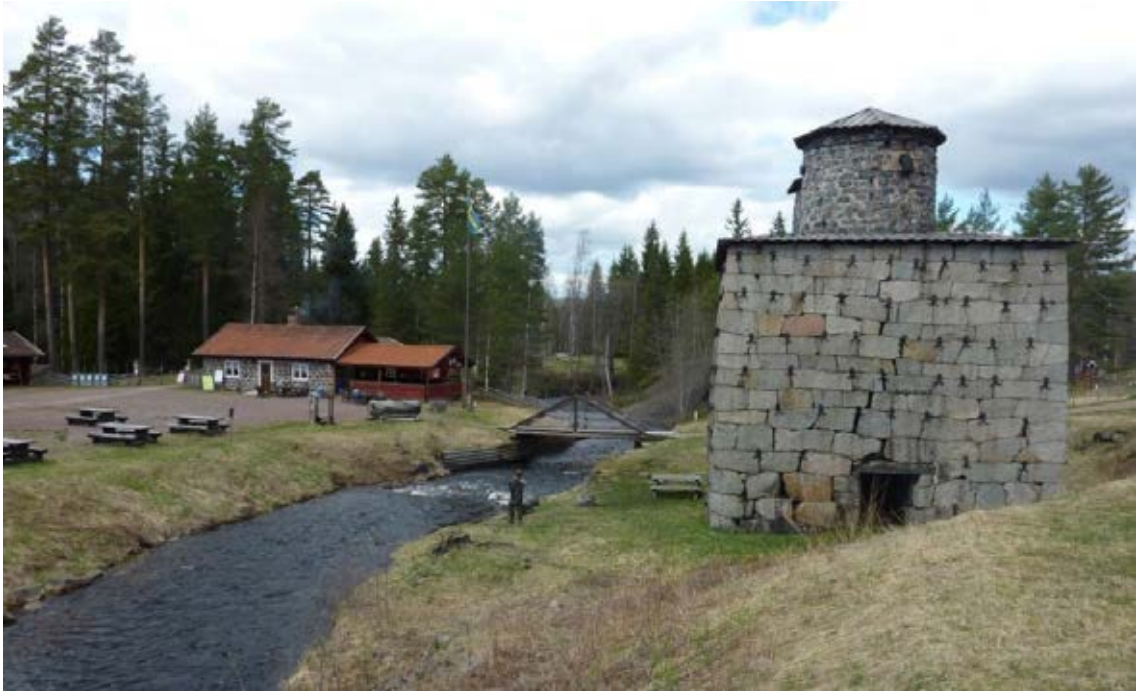
Bild 84. Masugnen som byggdes 1830 står delvis kvar. Tidigare fanns på samma plats två generationer multtimmershyttor från 1740 respektive 1760. Runt stenbyggnaden av granit har en träbyggnad funnits. Malm, kol och kalk fylldes på längst upp i ugnen. Det som nu utgör ett tak var tidigare ett golv. Foto: Christer Karlsson, 2015.
