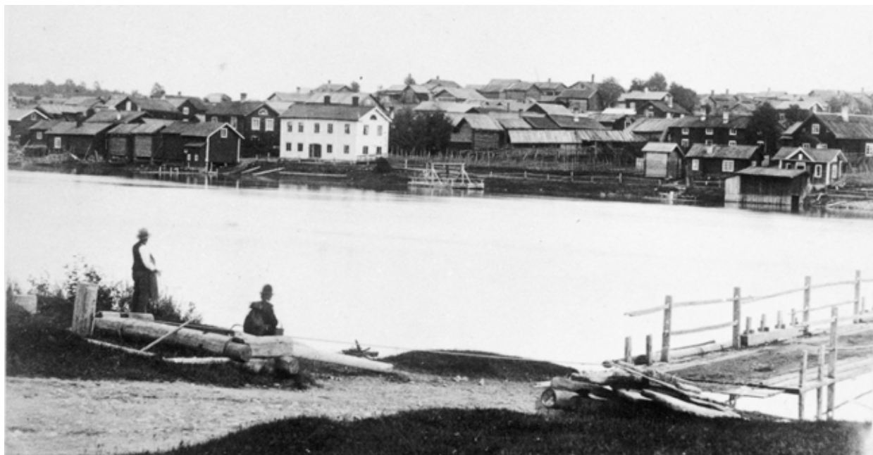
Bild 51. Flottbrons landfäste vid broåkern med Mora-Noret på andra stranden. Okänd fotograf. Jämfört med Bild 50 saknas den lilla byggnaden framför det vita huset, vilket tyder på att denna bild är äldre. Enligt Bertil Skeri, Noret, är fotot taget efter branden 1869. Den lilla stugan i fotots högra kant är brostugan. Reprofoto av Sam Lawson.
